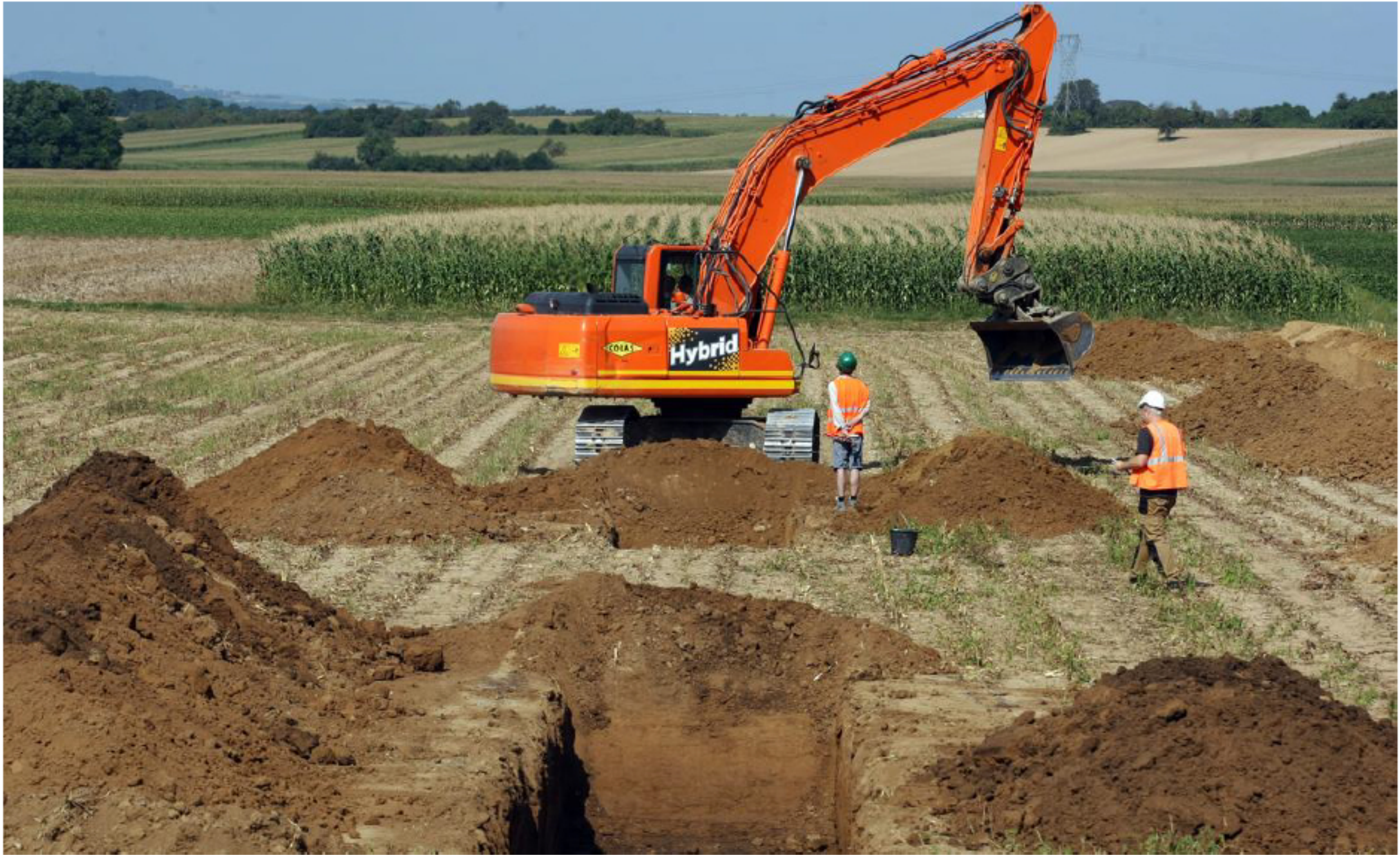
Fouille sur le site de la future centrale géothermique sur le ban d'Eckbolsheim. PHOTO DNA - LAURENT RÉA
