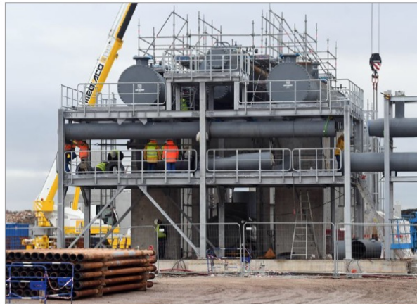
La centrale en cours de construction à l'Ecoparc de Vendenheim-Reichstett : elle devrait être opérationnelle pour le printemps 2020. Photo DNA/Franck DELHOMME
